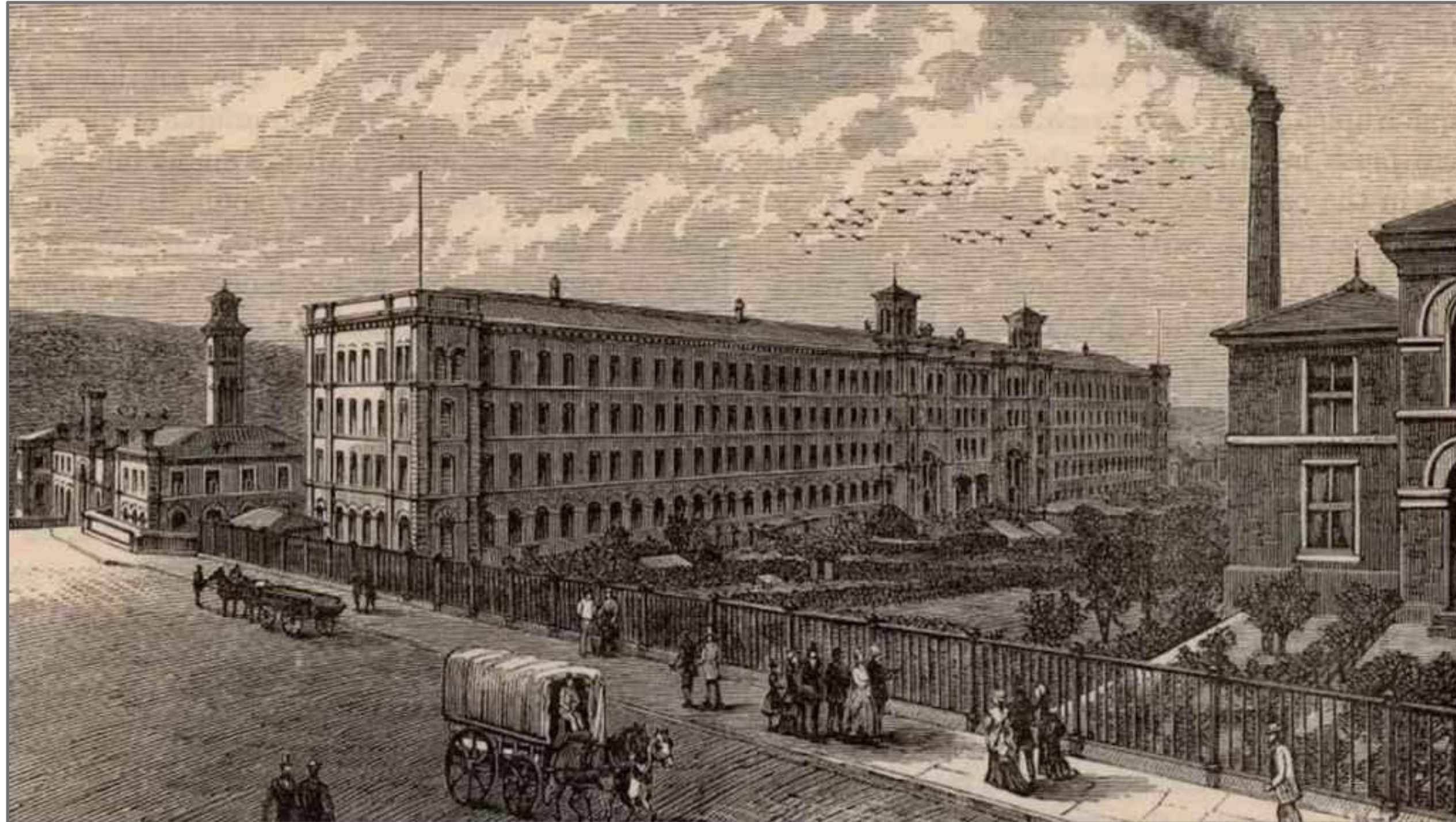
Bonaplata, Vilaregut i Cia Primera fàbrica instalada en Barcelona Carrer Tallers, 1820
